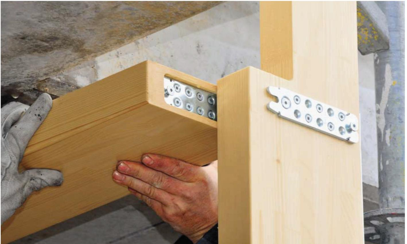
▲ Die Riegel mit eingelegten Trägerplatten lassen sich ganz einfach in das aufgeschraubte Verbindergestück schieben
